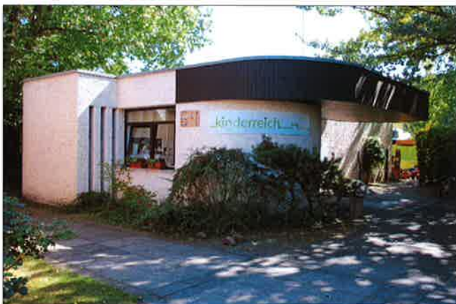
La crèche « Kinderreich » à Siegburg, construite en 1975, en 2013. Le bâtiment fut chauffé à l'aide d'un chauffage MULTIBETON pendant 38 ans.
